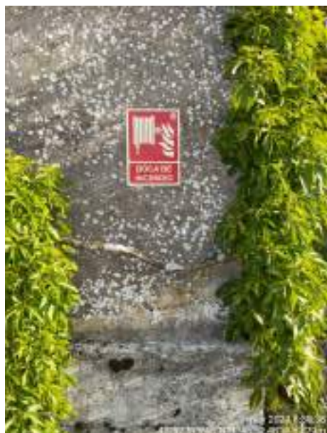
Figura 22: Señal BIE ubicada en Ochovi y ejemplo de señal de localización de hidrante que cumple Norma UNE 23033
