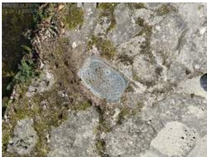
Figura 21: Boca de riego
