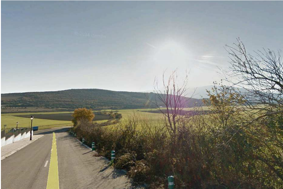
Zona de El Monte, zona forestal atravesada por el primer túnel que cruza la montaña hacia el valle de Ochovi.
